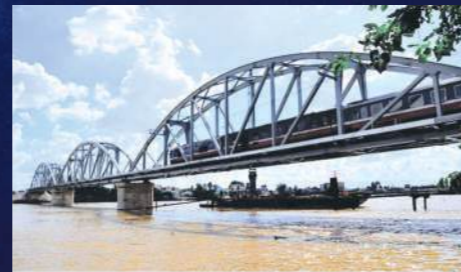
Cầu Ghềnh - Đồng Nai Ghenh Bridge - Dong Nai
